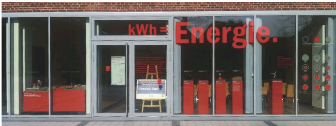
Abbildung 36: Gläserne Heizzentrale in der Gemeinde Saerbeck
