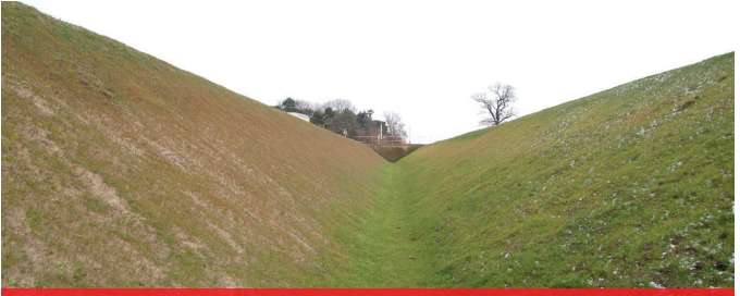
Wiederhergestellter Wehrgraben im Westen des südlichen Lagertores.
