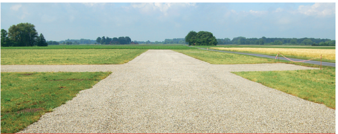
Abbildung einer wiederhergestellten Straße im Römerlager Anreppen.
